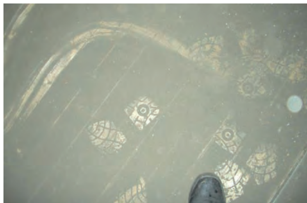
Figura 12 - La existencia de capas finas de polvo depositado puede ser suficiente para formar una atmósfera explosiva peligrosa. Cuanto más fino y seco sea el polvo inflamable, mayor peligrosidad. El polvo depositado debe ser eliminado.
