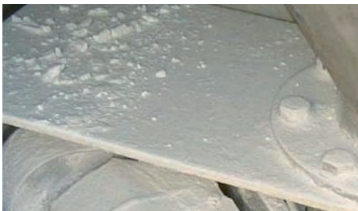
Figura 17 - La acumulación de polvo debe ser evitada. Un procedimiento de limpieza adecuado puede evitar la clasificación de la zona.
