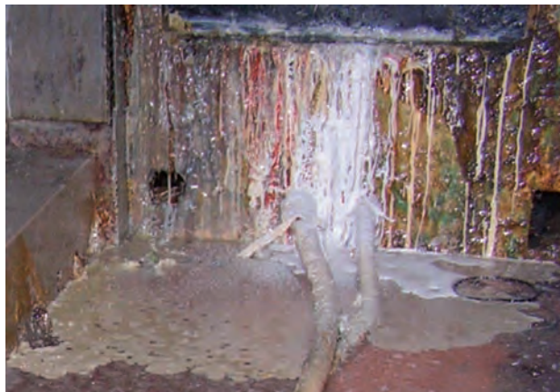
Figura 16 - Los derrames y acumulación de sustancia inflamables deben ser eliminados inmediatamente con procedimientos adecuados para evitar su filtración.
